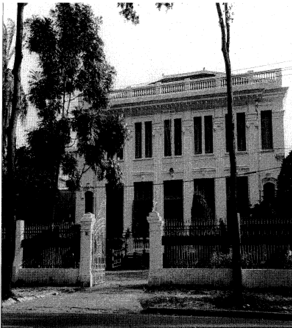
Fig. 2. — Villa coloniale à Saïgon : la véranda périphérique nécessaire à la régulation thermique de l'habitation prend la forme d'un décor de pilastres ioniques.
